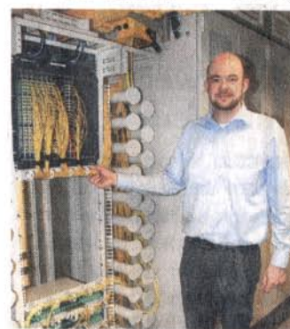
Das ist der „Point of Presence“: Projektleiter Florian Unger zeigt, wo die Signale empfangen und weitergeleitet werden.
